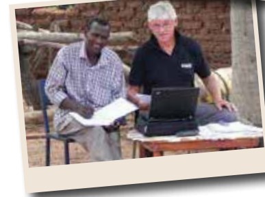
Bau des zweiten Trakts der Grundschule B in Fakena
