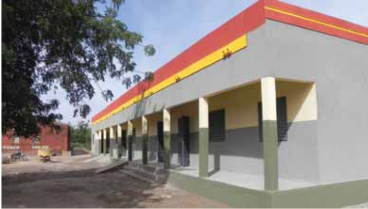
Fertiggestellter Schulblock der Grundschule B
