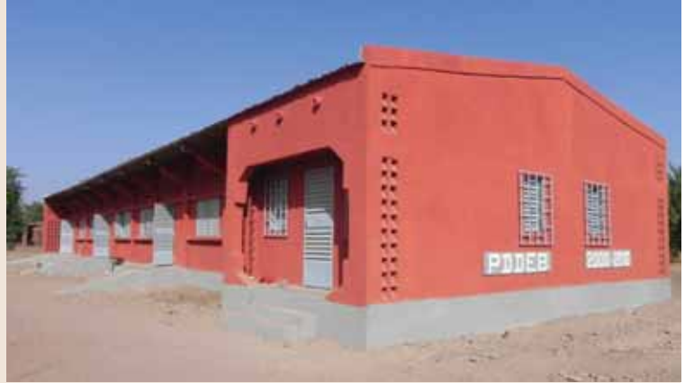
Renovierter Schulblock der Grundschule B
