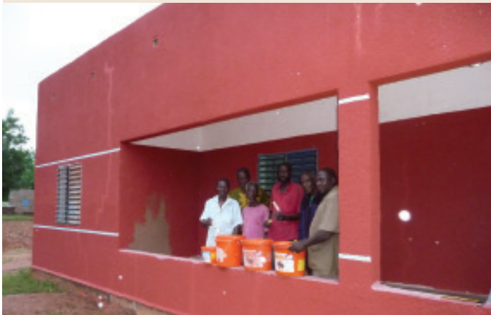
Nach der gelungenen Sanierung
