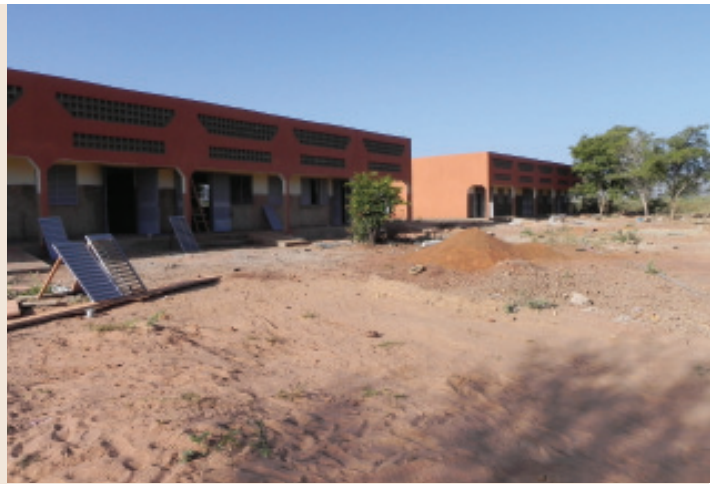
Das fast fertige Schulgebäude im Jänner 2011
