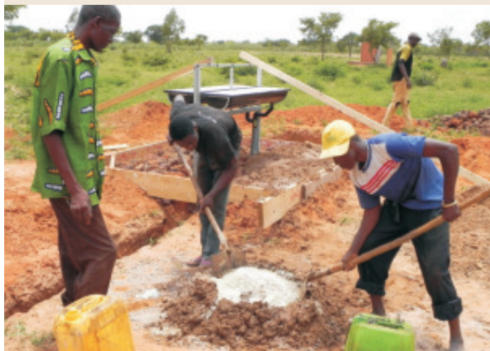
Betonierarbeiten an der Wasserstelle
