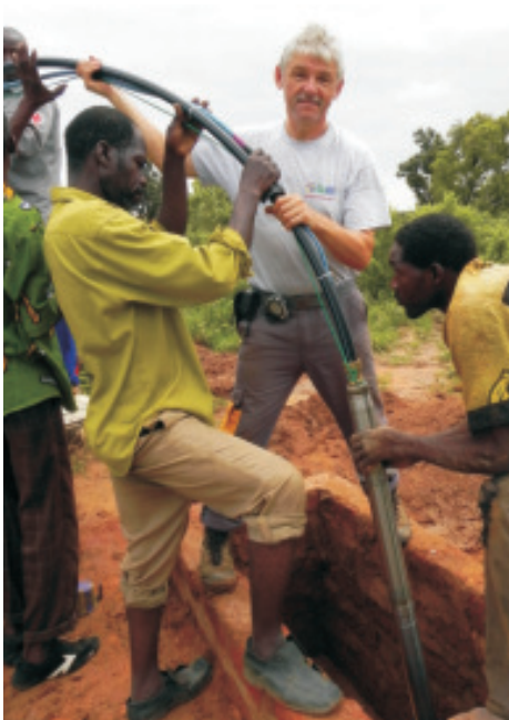
Wasserpumpe wird hinunter gelassen
