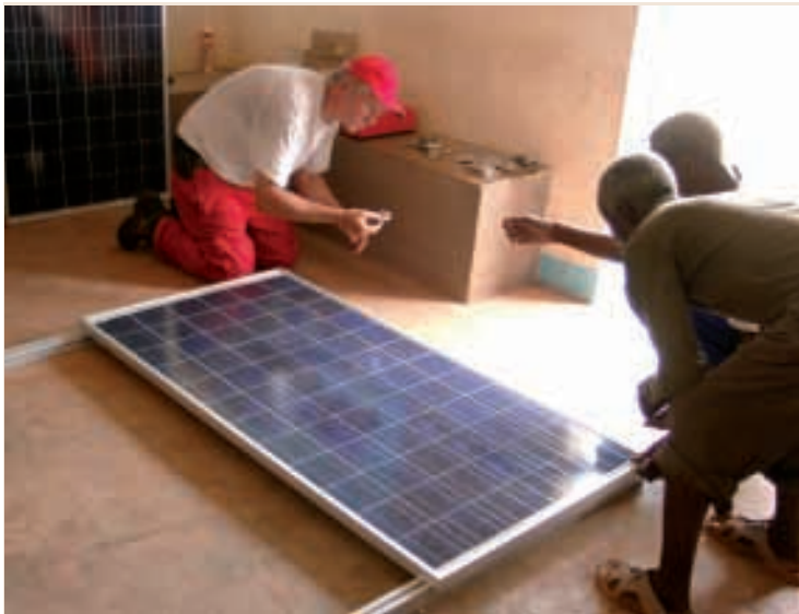
Zusammenbau der Photovoltaik-Anlage
