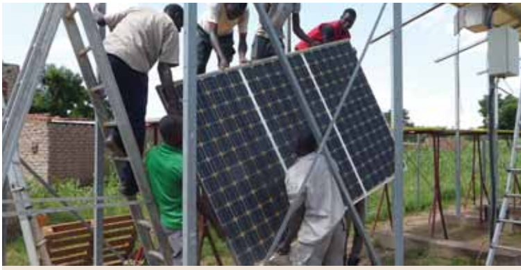
Demontage der PV-Module
