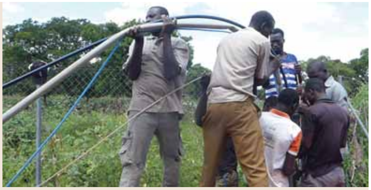
Absenken der Unterwasserpumpe
